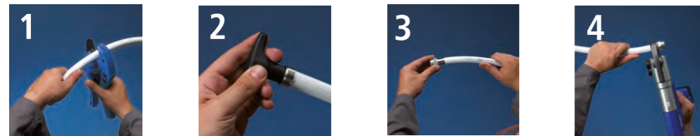
1 Cortar el tubo. 2 Calibrado-biselado del tubo. 3 Ensamblar accesorio. 4 Prensar.
