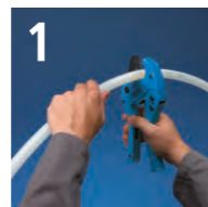
Cortar el tubo.
